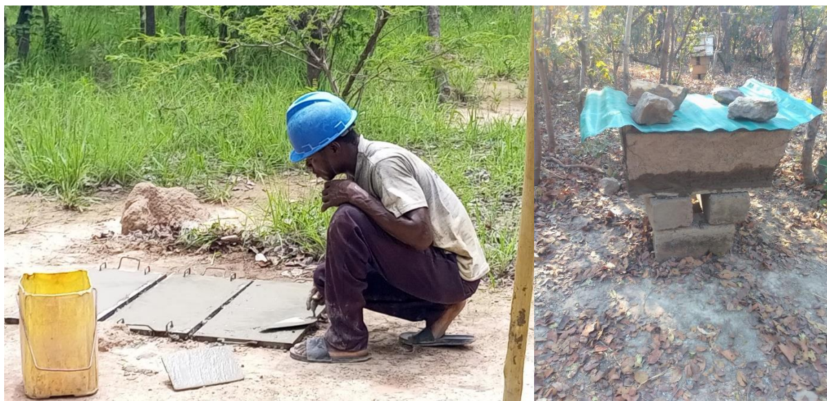
Construction et installation de ruches en béton
